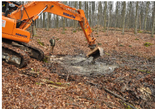
Überprüfung der Mächtigkeit der alten Lehmschicht
