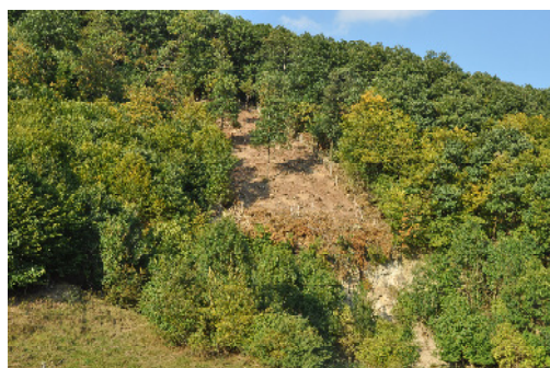
Ende August: die Arbeiten am 1. Schlag sind abgeschlossen.
