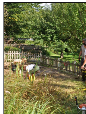
Der Stationsteich wird entkrautet
