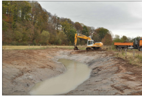
Oktober 2012: 50 m des alten Flussbettes der Emmer wurden wieder hergestellt
