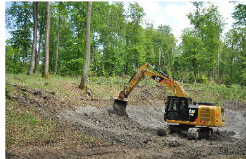
Abdichtung des neu profilierten Gewässers mit einer Lehmsschicht
