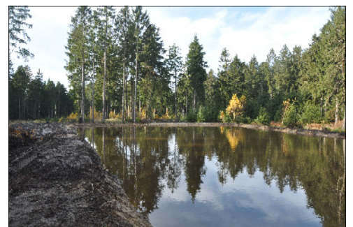
November 2019 | Sanierter Scerosenteich mit verdichteten Uferwällen
