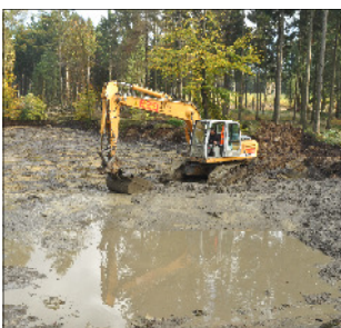
Der Bagger bei der Arbeit
